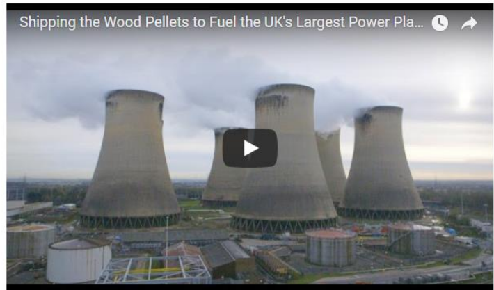
La centrale électrique de Drax au Royaume Uni est parmi les plus larges à opérer une transition du charbon vers le bois
