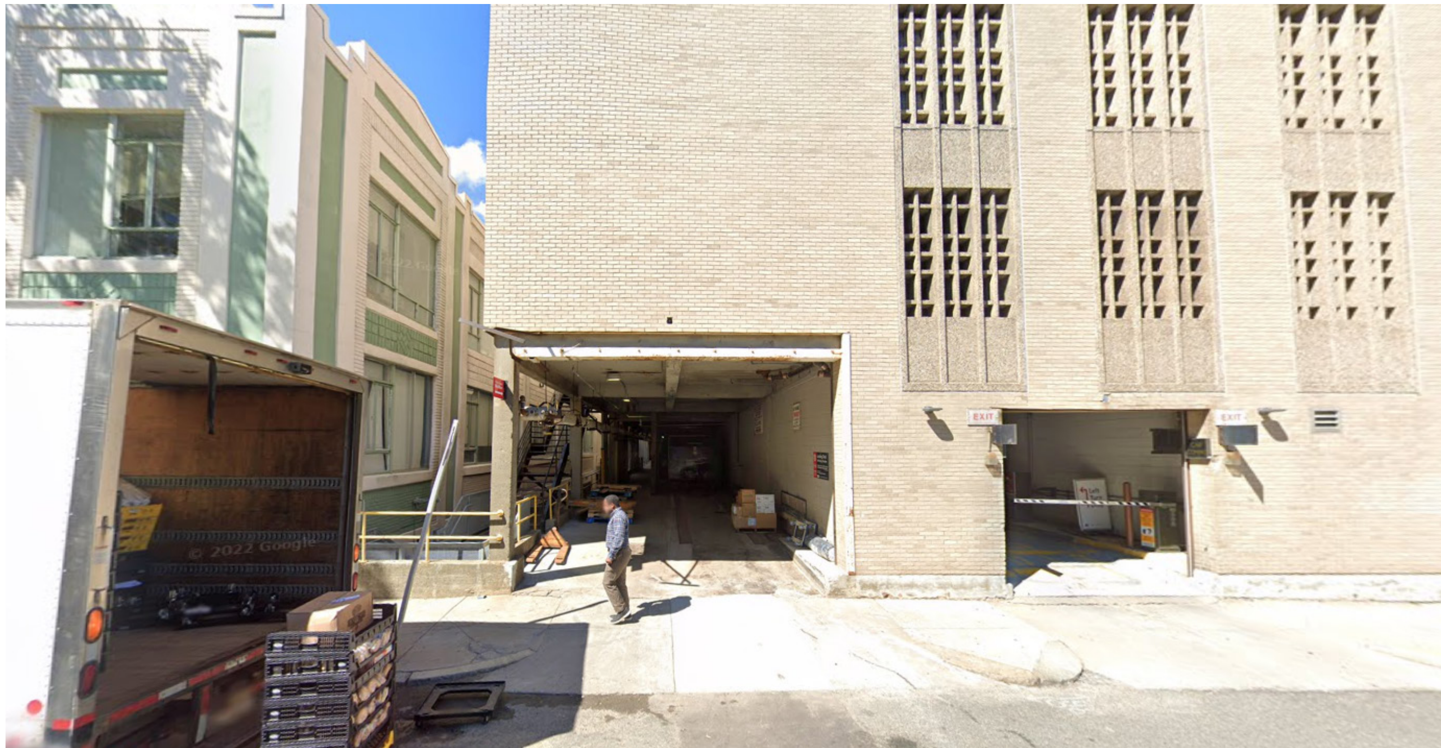
Corredor entre el estacionamiento Warren Towers (K) y 111 Cummington Mall en Hinsdale Mall
