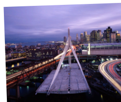
Peter Vanderwarker. The Big Dig , 1995-2004.
