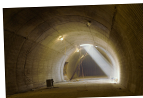
Peter Vanderwarker. The Big Dig , 1995-2004.
